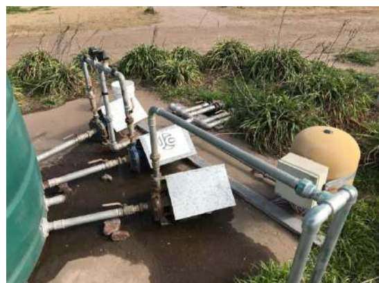
Foto 33 y 34. Dos bombas entregan agua a la placa pre-enfriadora de leche, y desde ahí a tanques verdes cerrados.
